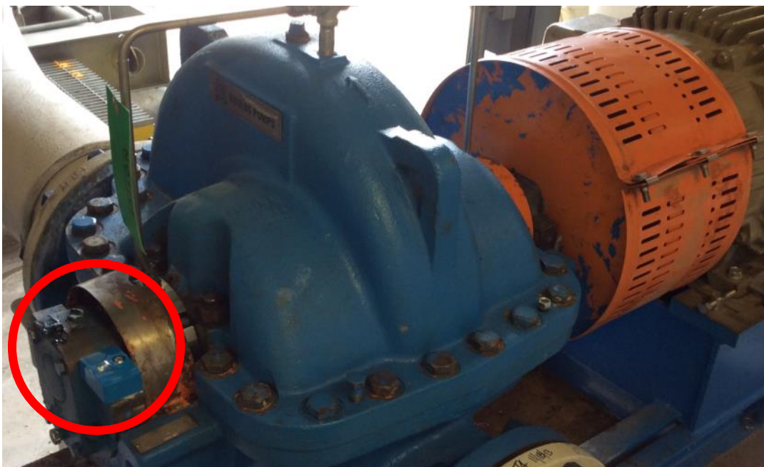
Figura 18: Bomba doble succión, carcasa partida horizontal, instalación en la caja de rodamiento de empuje
