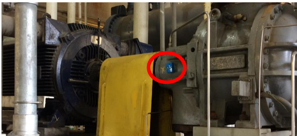
Figura 22: Bomba de vacío, montaje lateral en caja de rodamientos
