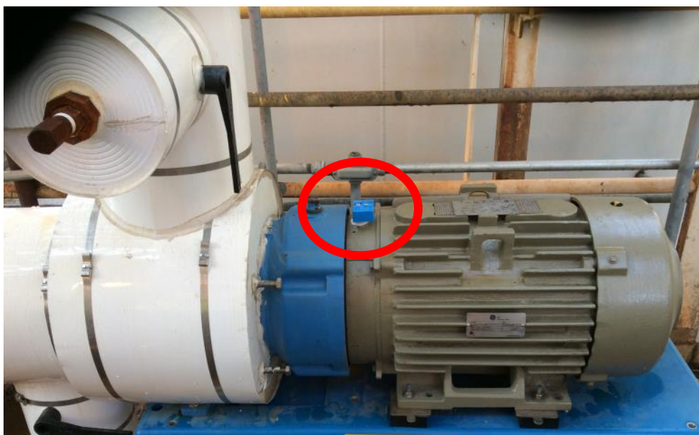
Figura 16: Motor de acoplamiento corto, instalado en la caja de rodamientos lado acople
